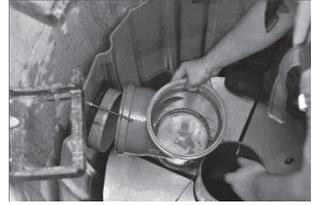
3. T-Stück (am Ablauf) einsetzen, wenn alle vier Filter eingebaut sind
