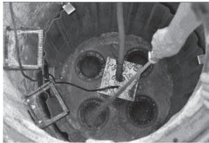
5. Dichtungen für die Filterelemente gründlich spülen
