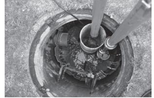
3. Durchfluss so lange steigern, bis Oberkante des Wartungsrohres oder Leistungsgrenze der Pumpe erreicht ist; zehn Minuten im stationären Zustand pumpen
