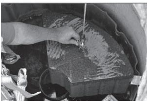
1. Seilzug in Filteröse einhaken und Filter ganz aus dem Schacht herausziehen
