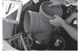
3. T-Tück komplett herausnehmen und aus dem Schacht herausheben
