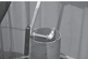
1. Einbringen der Spüllanze über das Wartungsrohr. Spülkopf unterhalb eines Filterelementes positionieren. Schmutzwasserpumpe über Filterelementen positionieren und einschalten.
